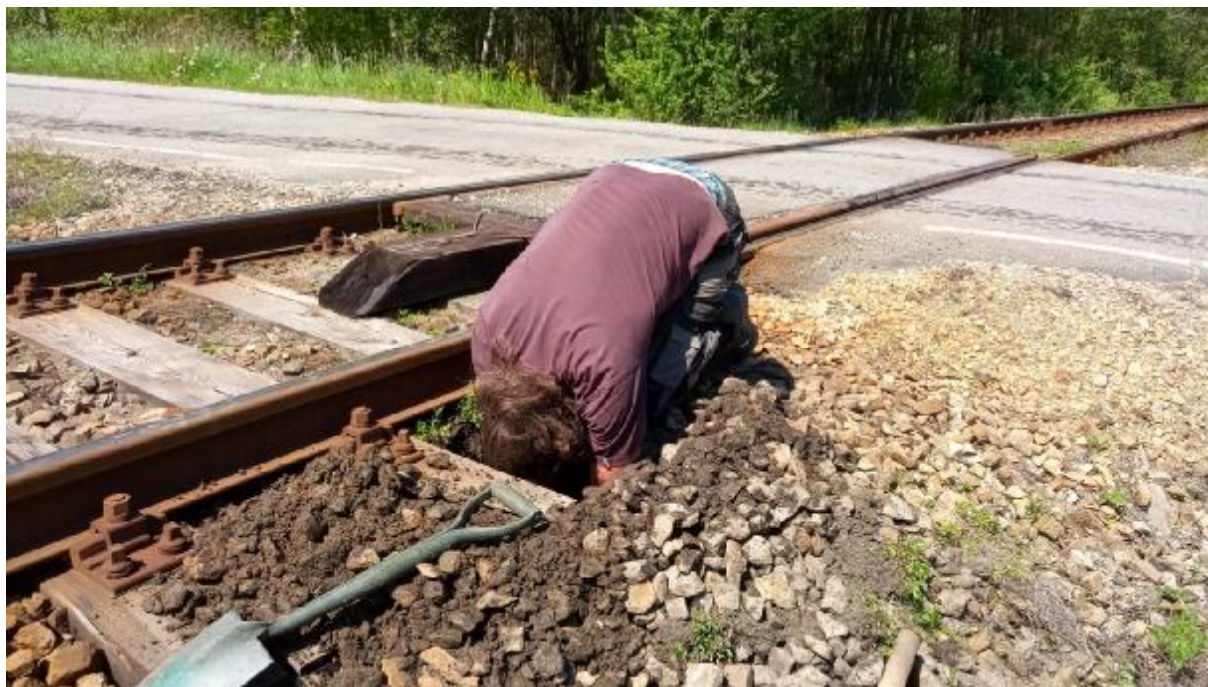
Pohled na místo realizace kopané sondy K1 (přejezd P1467)
